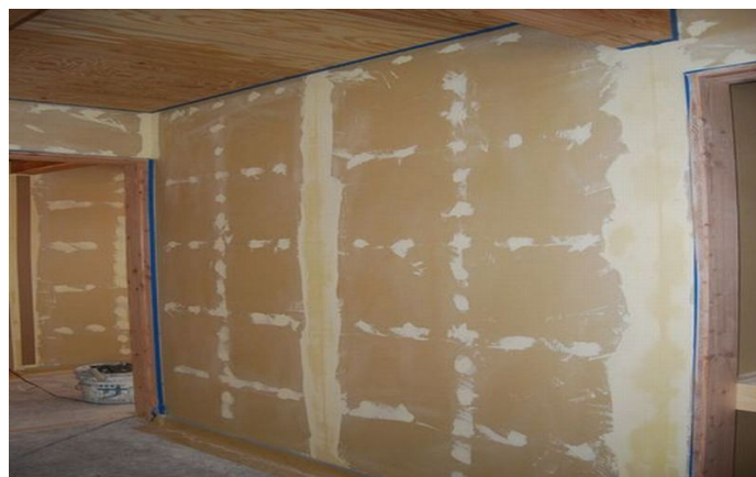
ジョイント処理完了
